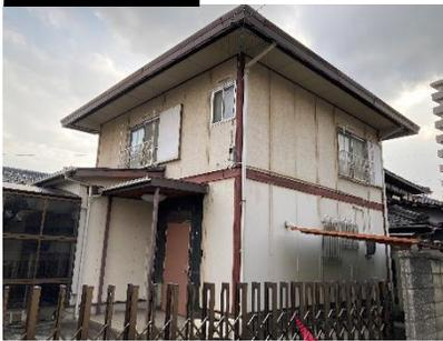
塗れるものは全て塗り替えさせていただきました！鉄製の付帯部は、錆びて塗膜が剥がれてしまっている箇所が多くありました。劣化塗膜はケレンで出来る限り取り除き、下塗りにはサビ止めを使用し、新しい塗膜で保護！
